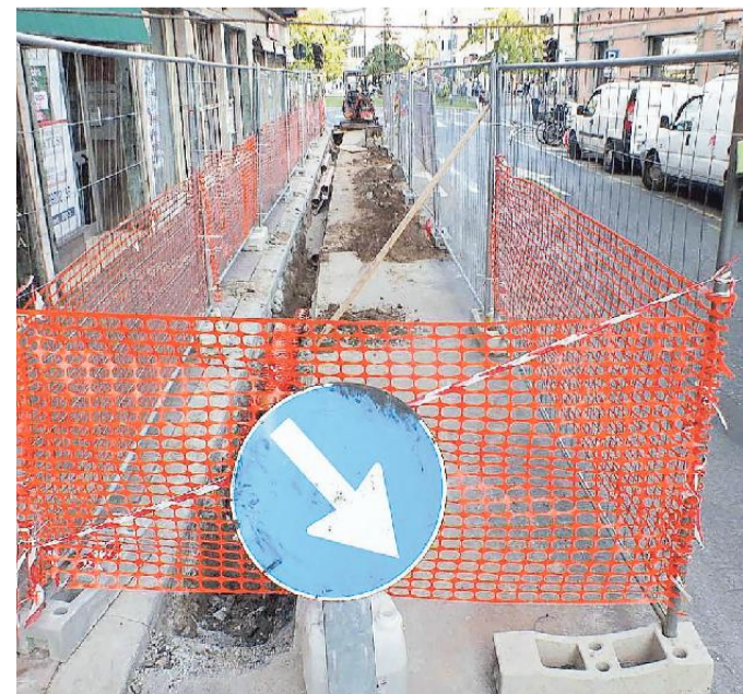
Gli interventi sulla rete fognaria
