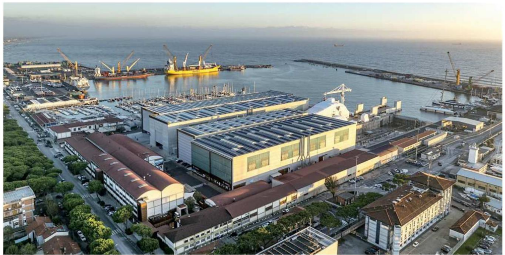
Nella foto in alto una veduta del cantiere di Marina di Carrara
