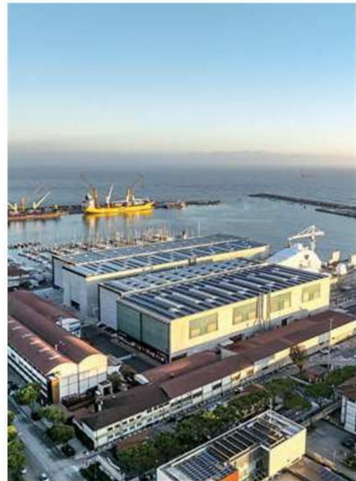
Uno scorcio dei cantieri The Italian Sea Group
