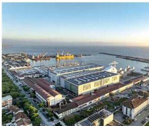
Una panoramica dei cantieri di The Italian Sea Group leader nel settore della nautica di lusso
